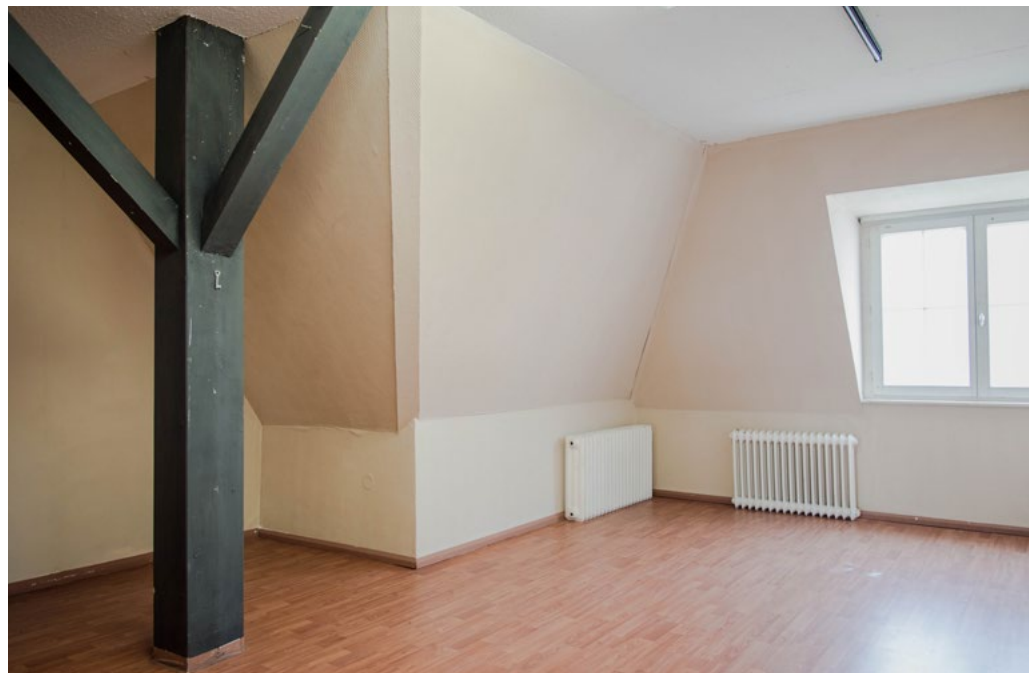
Zimmer im Dachgeschoss
